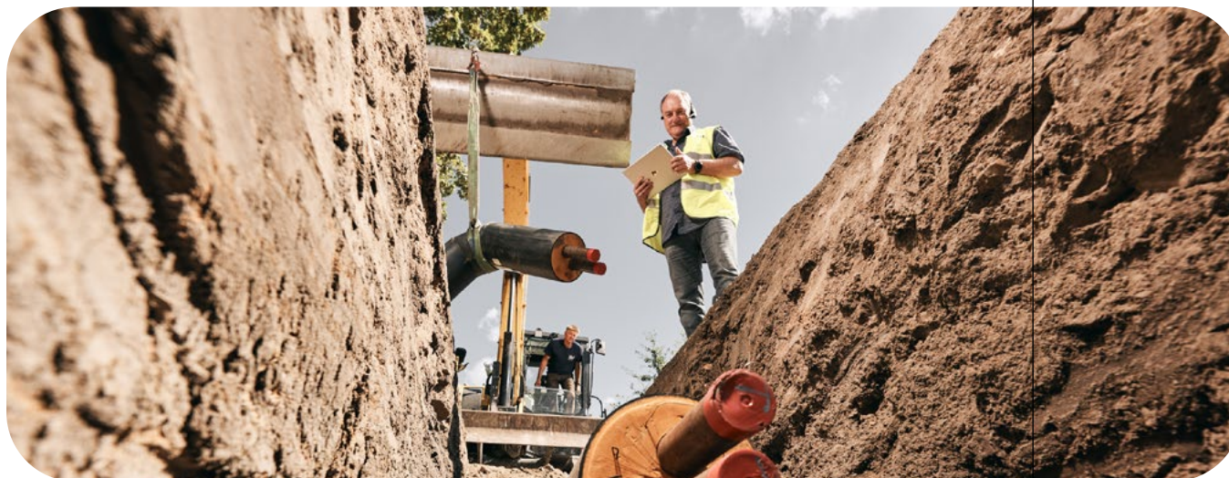
Bau einer Wärmeleitung
