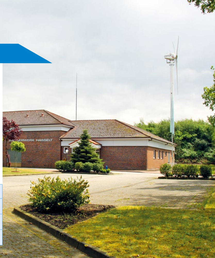
Wasserwerk Hasselt mit Enercon-Windenergieanlage.
