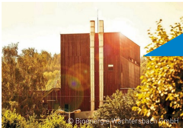
Holzackschnitzel-Heizkraftwerk der Bioenergie Wächtersbach
