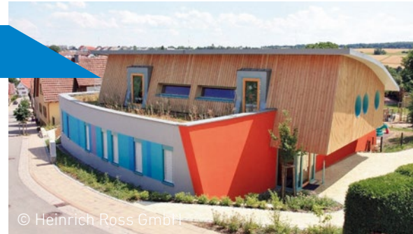
Plus-Energie-Kindergarten im Ortsteil Serres
