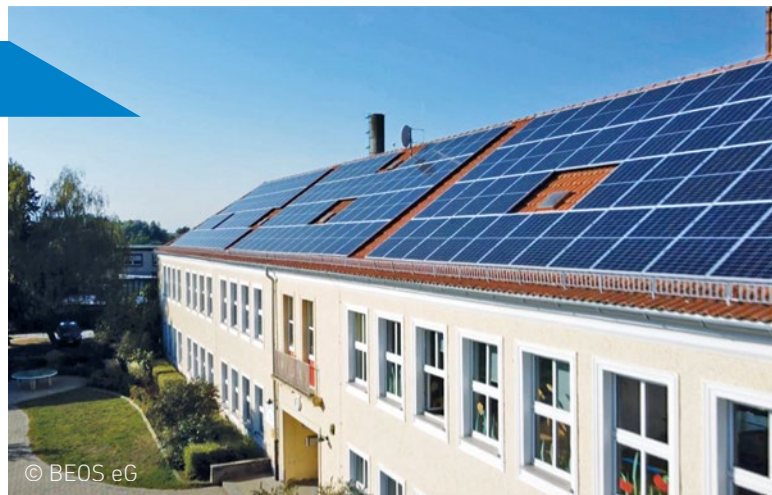
PV-Anlage auf dem Dach der Kita Heinersdorf
