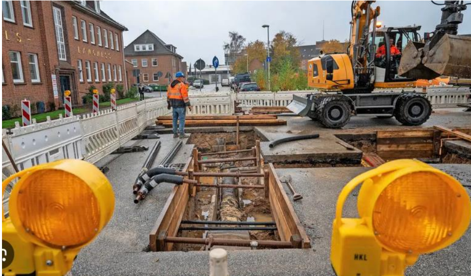
Beispielhafte Baustelle in Kiel
