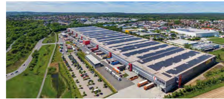
ETWA 1.625 HAUSHALTE KÖNNEN, MIT DER PV-ANLAGE DES UNTERNEHMENS FIEGE, NACHHALTIG MIT STROM VERSORGT WERDEN.
