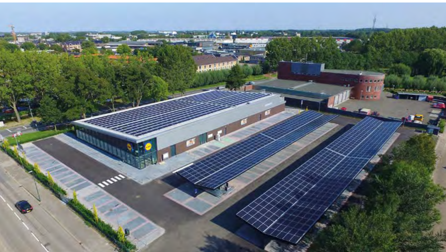
DIE ENERGIENEUTRALE LIDL-FILIALE IN WOERDEN SETZT DIE SONNENENERGIE AUCH FÜR DIE PRODUKTKÜHLUNG EIN.
