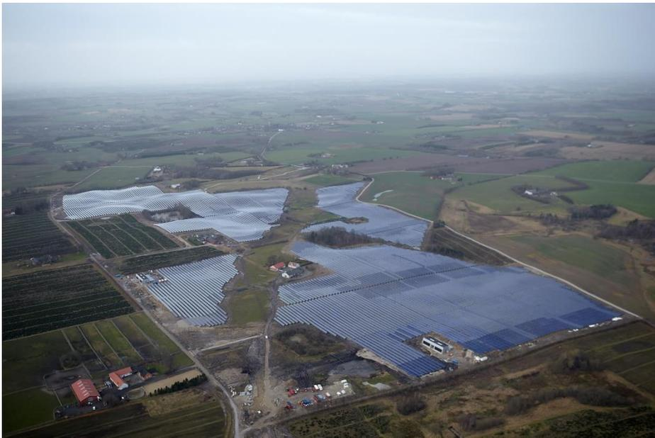
Abbildung 27: Weltweit größtes solarthermisches Kollektorfeld in Silkeborg mit 156.694 m<sup>2</sup>. Das Netz versorgt 4.400 Haushalte (mit freundlicher Genehmigung von Arcon-Sunmark)
