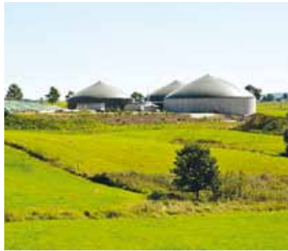
Effizient und flexibel erzeugt die Biogasanlage Lebach Strom und Wärme aus Mais, Gras, Gülle und Mist.
