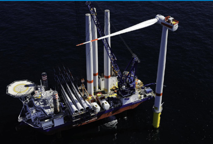
Installation des Rotorblatts an einer Offshore-Windenergieanlage.
